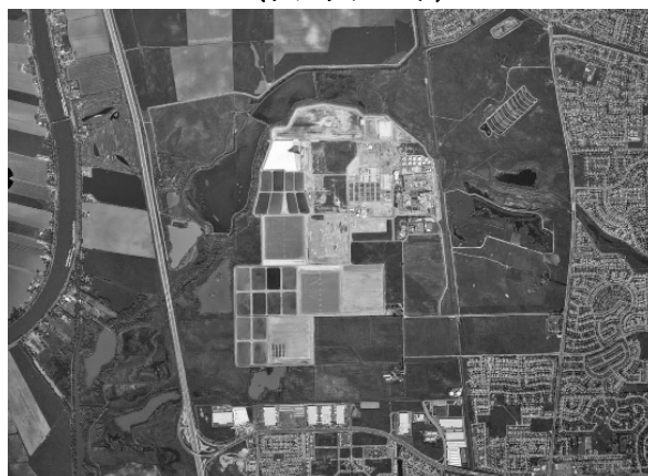
図表 自然保護区に囲まれた下水処理場 (サクラメント)
