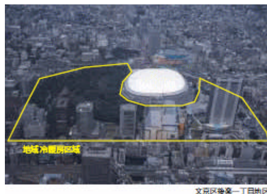
写真 1 後楽一丁目熱供給区域航空写真
