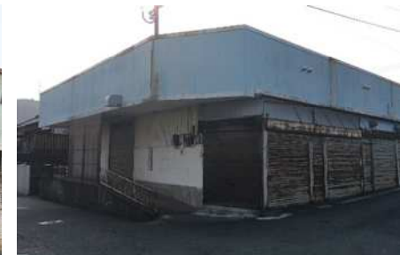
長期にわたって開閉していない錆びたシャッター
