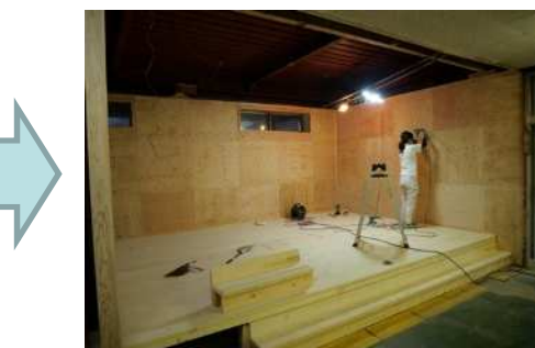
改修作業の様子
