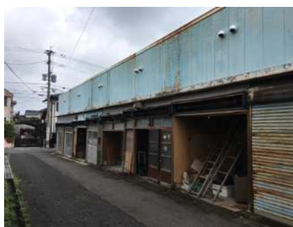
シャッタの取り壊し
