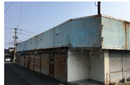
長期にわたって開閉していない錆びたシャッター
