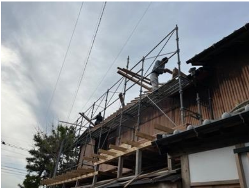
⑤借主負担による改修工事
