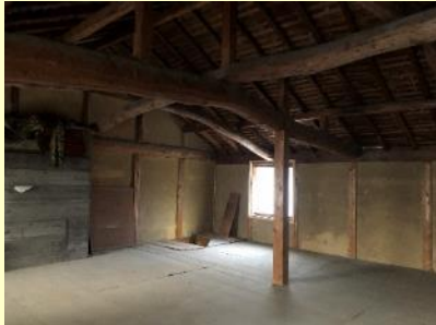
対 象 空き家 施工前
