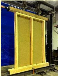
空き家モデル 施工前
