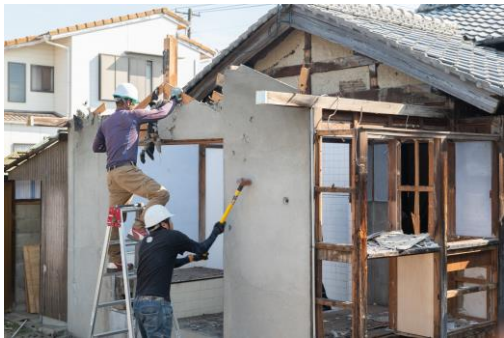
解体（改築）の様子 重機を入れず、段階的に作業を進めた
