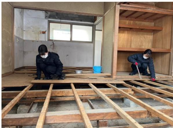
写真4 床板の撤去
