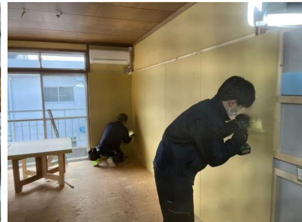
写真6 石膏ボードの取り付け
