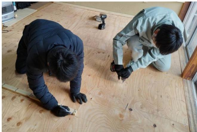
写真5 内部床のビス打ち
