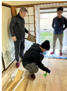
フローリング張り
