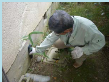
基礎鉄筋探査
