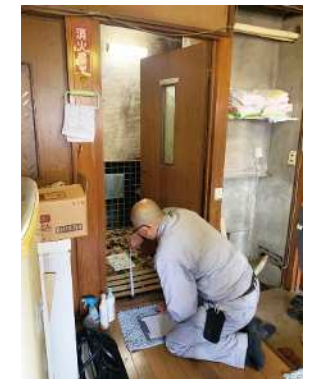
D.その他相談窓口 補修工事の様子
